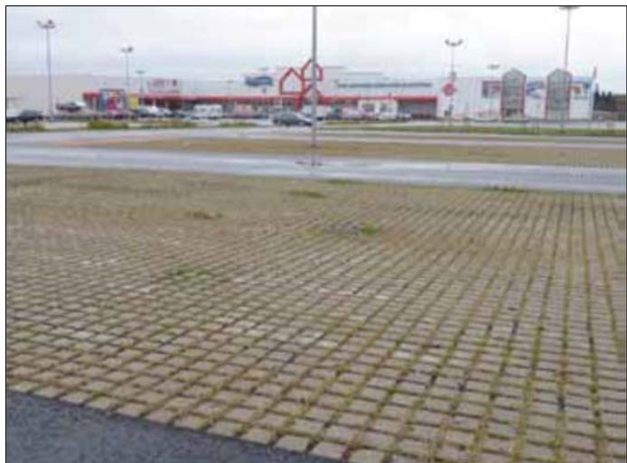
Kuva 74. Esimerkkikuva laatoitetusta pysäköintialueesta. Laatoitukset toimivat pysäköintipaikkojen läpäisevänä päällysteenä vähemmän käytetyillä osalla. Lähde kuntaliitto hulevesiopas, Jukka Jormola.
