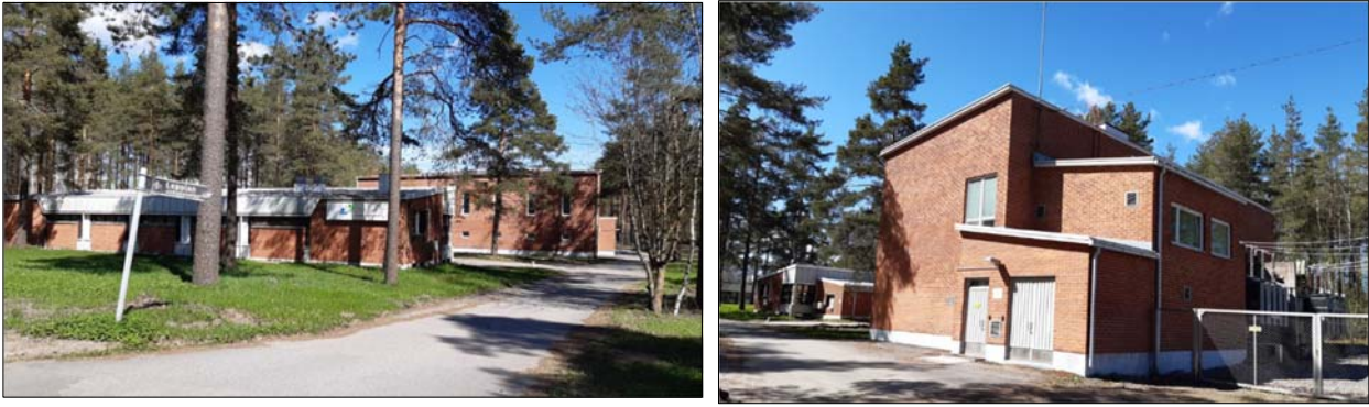
Kuva 23. Vasemmalla Etelä-Karjalan hyvinvointialueen ensihoidon ja sairaankuljetusyksikkö Lepolankatu 11 ja oikealla Lappeenrannan Energiaverkot Oy:n Lepolan sähköasema.
