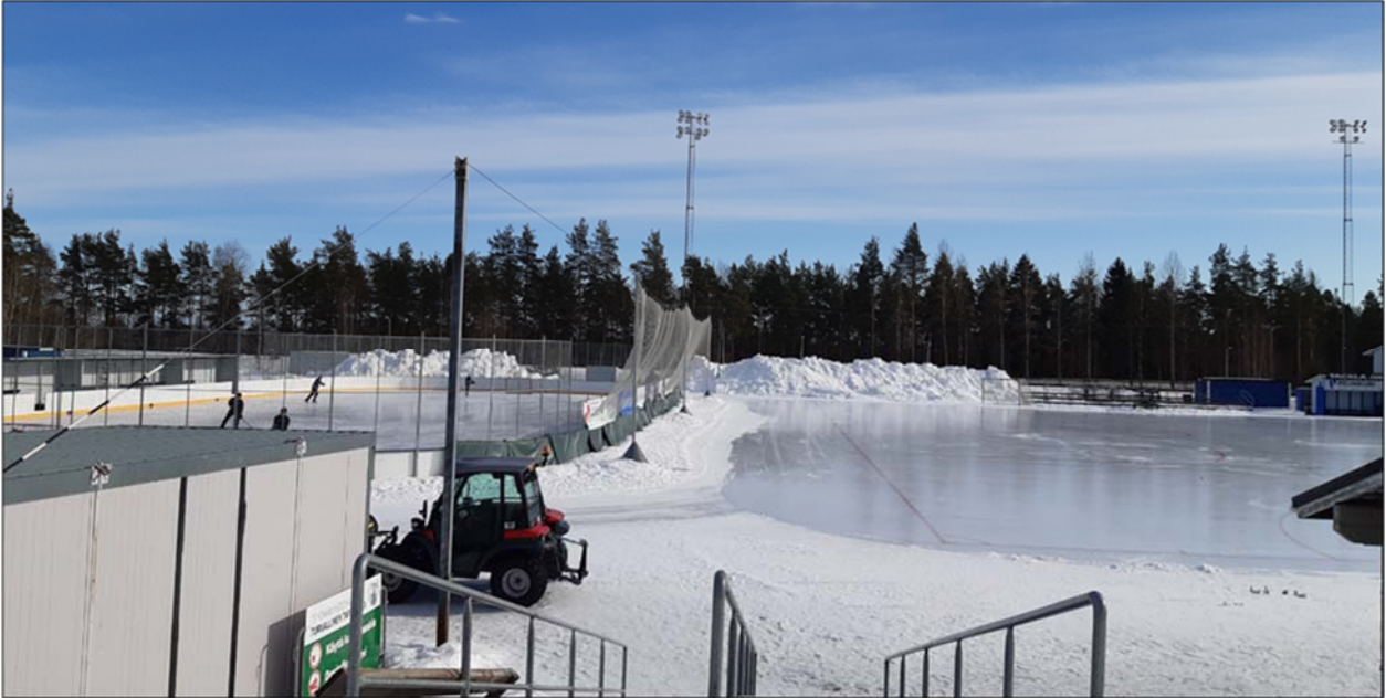
Kuva 34. Ison tekojääradan itäpäässä on myös kaukalo.
