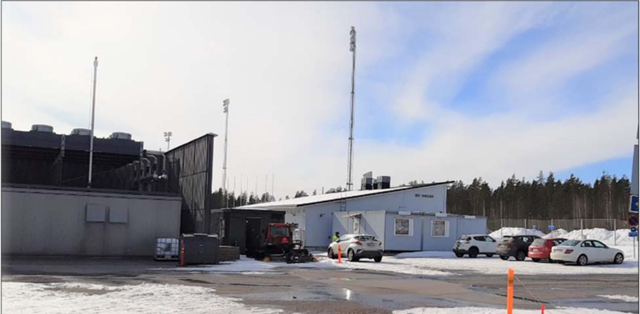
Kuva 35. Ison tekojääradan itäpäässä on Veiterän edustusjoukkueen pukukopit ja vuonna 2016 uusittu hallien jäähdytyslaitteisto.
